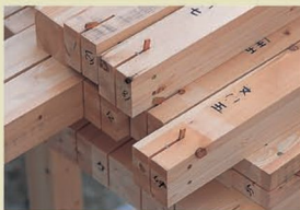
木材の端部にある金物の留め具
