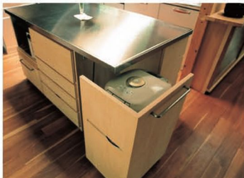
中央カウンターに組み込んだ炊飯器収納
