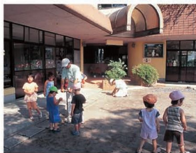
幼稚園で行われた埋設工事
