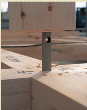
土台と柱の連結部
