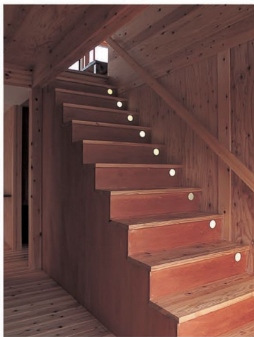
風呂込みに埋め込んだオリジナル階段照明
