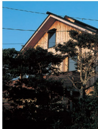
越し屋根の下は排気口になってる
