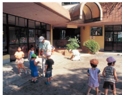
幼稚園で行われた設置工事
