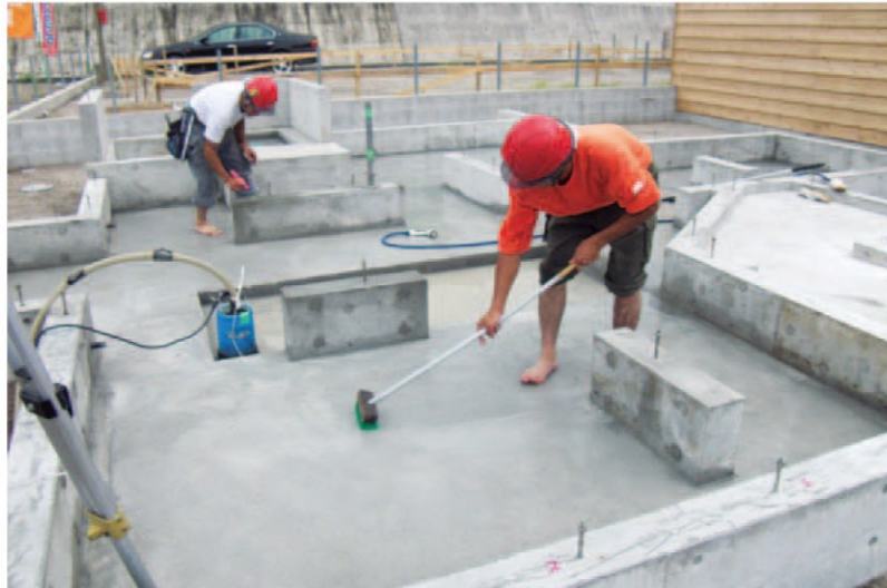
太陽熱を蓄熱するための基礎・床下は大切。建て方前に必ずフリーマーがきれいに磨き上げる
