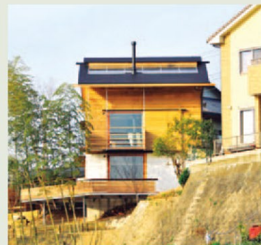
上写真の池側からのようす。土地選びは、気持ちのいい場所探し
