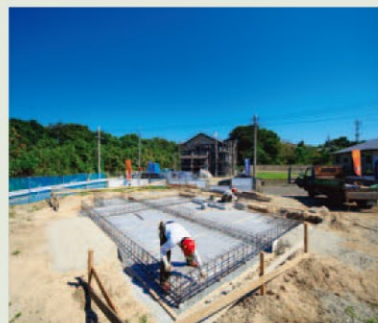
一体打ちの基礎工事も見ることができます
