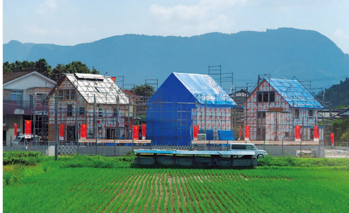
大切な骨組を雨で濡らさないための養生は作業後の日課。晴れていても養生を行なう
