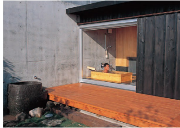
浴室北西側の壁は、隣との境界につくったコンクリート打ち放しの壁を利用したもの
